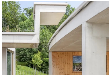
À l'étage, le passage protégé vers l'école élémentaire avec sa casquette anguleuse qui laisse filer la courbe de la toiture.
