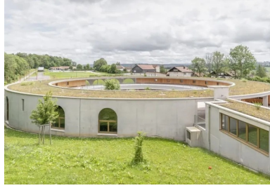
Encastrée dans le talus, l'extension ceinte par des murs de béton brut, sobres. La toiture végétalisée contribue à son insertion paysagère.
