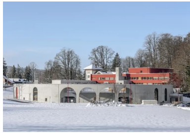
À travers les grandes arches cintrées qui marquent l'entrée se devine l'intérieur de l'école. Au second plan, le bâtiment réhabilité repeint en rouge.
