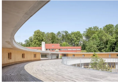
La cour des élémentaires, aménagée sur la toiture intermédiaire.
