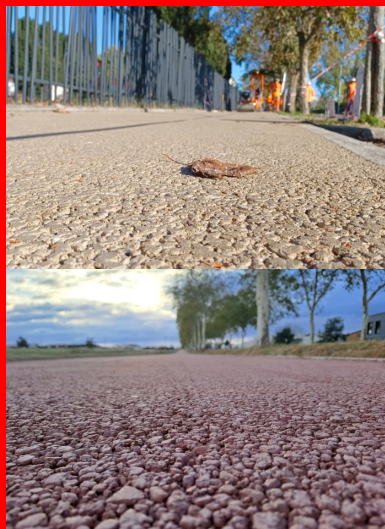
Piste cyclable en BCR poreux avec 90 % de gravas recyclés 4/10 et 10 % de sable roulé 0/4, à Lagord (17). (© Spie Batignolles Malet)
