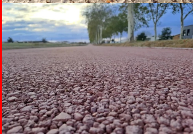
Piste cyclable en BCR poreux coloré rouge, à Pibrac (31). (© Spie Batignolles Malet)
