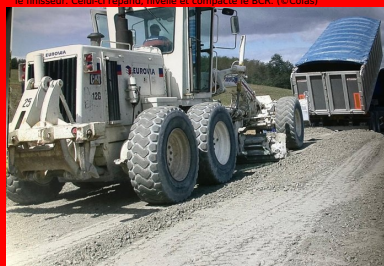
Un camion-benne, bâché durant le transport du BCR, déverse le matériau devant la niveleuse. Celle-ci répand et nivelle le BCR. (©Eurovia, X)
