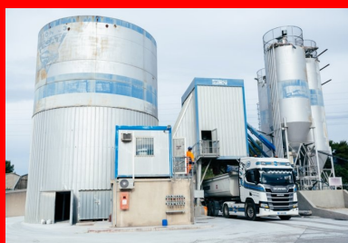
Centrale discontinue de type BPE, où le BCR est étudié et fabriqué. (© Béton Vicat)
