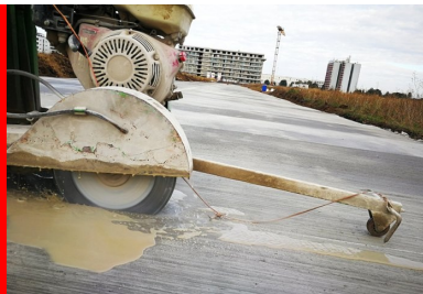
Sciage de joint sur chaussée en BCR. (© Colas)
