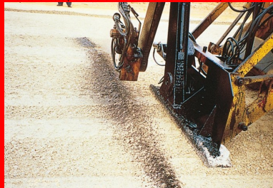
Réalisation de la préfissuration à l'aide de la machine Craft Emulsion®. (© Cimbéton)
