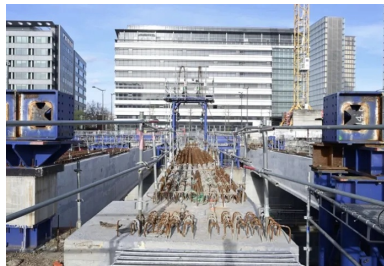
Vue d'une poutre à sa position définitive. Aperçu des équipements de manutention lourde : portique de levage et chemin de ripage.
