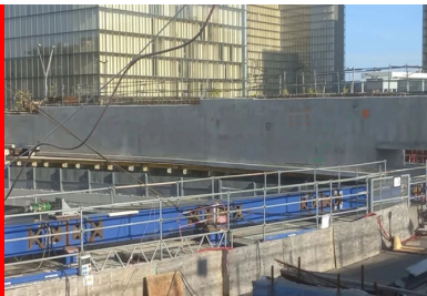
Les méga-poutres sont ripées sur des chemins de ripage, eux-mêmes appuyés sur des files situées 3 m plus bas par l'intermédiaire de palets.
