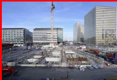
Intégration du projet dans son milieu urbain.
