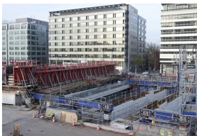
Vue globale montrant l'aire de préfabrication des méga-poutres (poutre coffrée, banches rouges).
