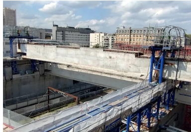
Des portiques de levage situés de part et d'autre de la méga-poutre permettent de descendre celle-ci jusqu'à sa position définitive, par l'intermédiaire de chevêtres brésés à la structure par des barres précontraintes.
