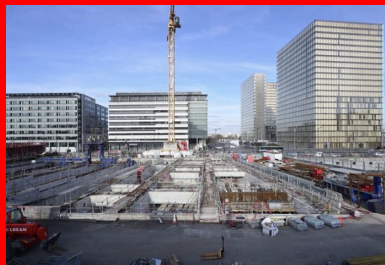
Intégration du projet dans son milieu urbain.
