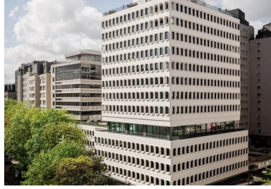
Une silhouette en 3 volumes superposés mise en valeur par deux niveaux atypiques et entièrement vitrés, le RDC et le R+4.
