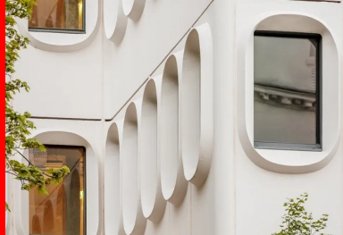
Réalisée in situ, la rénovation des façades béton valorise pleinement le dessin original de Marcel Roux.
