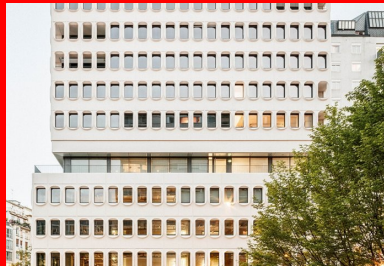
Une silhouette en 3 volumes superposés mise en valeur par deux niveaux atypiques et entièrement vitrés, le RDC et le R+4.
