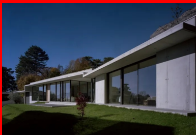
La façade principale se caractérise par l'articulation des volumes et le contraste entre généreuses surfaces vitrées et béton banché.
