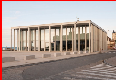
La position centrale de l'exosquelette de béton définit les deux espaces publics du grand parvis en béton sablé couleur sable micro-désactivé et du jardin qui longe la cale à l'arrière.
