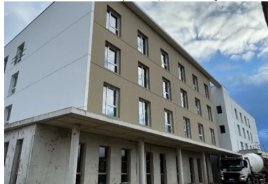
Chantier de l'ensemble EPHAD Pacy-sur-Eure [2] (DR Heidelberg Materials)
