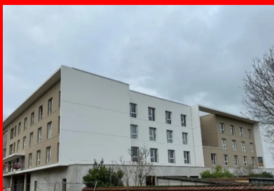
Chantier de l'ensemble EPHAD Pacy-sur-Eure [1] (DR Heidelberg Materials)
