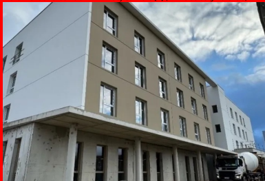
Chantier de l'ensemble EPHAD Pacy-sur-Eure [2] (DR Heidelberg Materials)
