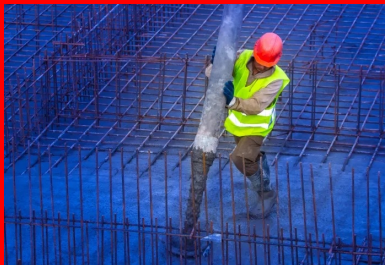
Déchargement BPE sur site
