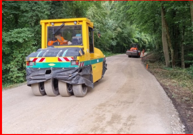
Un atelier de compactage en action. (©Colas)
