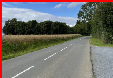
Réhabilitation de la RD119 achevée. (©Fenêtre sur cour)
