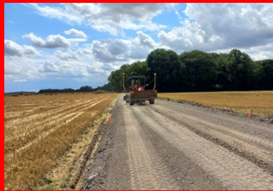
Régalez des fraisats d'enrobés et mise au profil à l'aide d'une niveleuse guidée par GPS. (©Colas)
