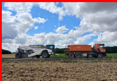
RD 119. Retraitement en place au liant hydraulique routier ROC VDS entre Briot et Briot-La-Grange. L'humidification du matériau est réalisée directement dans la cloche du malaxeur. (© Colas)
