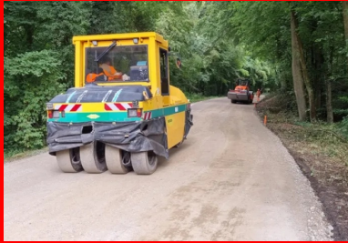
Un atelier de compactage en action. (©Colas)
