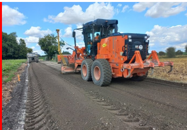
Le retraitement au LHR est suivi par un nivellement et la mise au profil du matériau. (©Colas)
