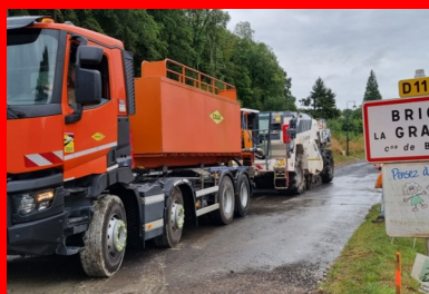
Etat de la RD119 avant les travaux. (© Colas)
