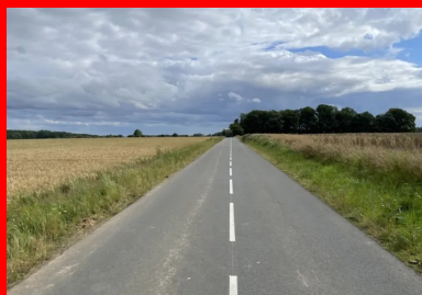
Réhabilitation de la RD119 achevée. Accotements rehaussés et signalisation horizontale réalisée. (©Fenêtre sur cour)
