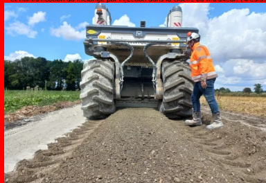
Aspect du matériau retraité après le passage du malaxeur. (©Colas)
