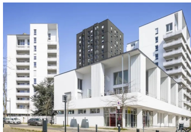
Les deux volumes verticaux du projet dialoguent avec les tours existantes et en atténuent la présence dans le paysage.
