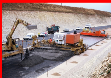
RN 141. Déviation des Rassats-Favrauds- Mise en oeuvre de la chaussée composite en BAC/GB3 en 1998. Cette structure assure parfaitement son rôle aujourd'hui sans avoir fait l'objet d'entretien structurel (cf. interview Gilles Lacassy, DIRA).
