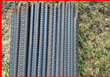
Armatures longitudinales du BAC
