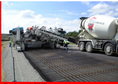
Chaussée composite BAC/GB3
