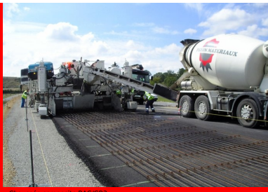
Chaussée composite BAC/GB3
