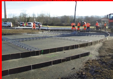
Mise en œuvre d'une structure en BC5g/GB3. La propreté de la grave bitume est indispensable pour assurer le collage à l'interface béton/grave bitume.
