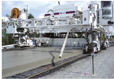
Mise en œuvre d'une structure en BAC/GB3. La propreté de la grave bitume est indispensable pour assurer le collage à l'interface béton/grave bitume.
