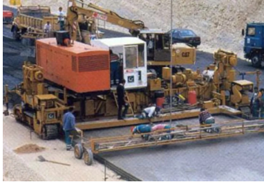
Mise en œuvre du béton à l'aide d'une machine à coffrages glissants.
