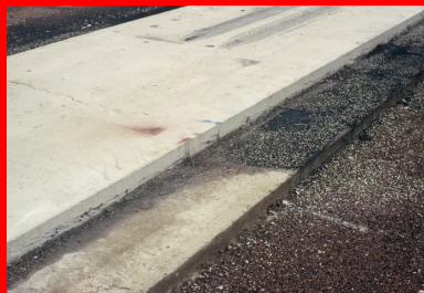
Les résultats de FABAC. Tenue de la structure après plusieurs millions de passages d'Essieux Standards.
