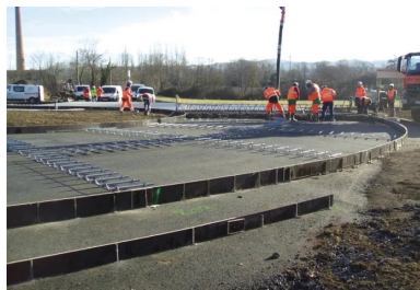
Positionnement des goujons sur des paniers avant le bétonnage.
