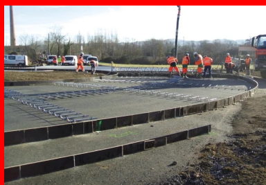
Positionnement des paniers sur des paniers avant le bétonnage.
