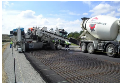
BAC. Positionnement des armatures longitudinales sur des supports ou « distanciers ».
