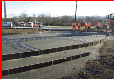
Mise en œuvre d'une structure en BC5g/GB3. La propreté de la grave bitume est indispensable pour assurer le collage à l'interface béton/grave bitume.
