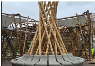
Piédestal central - bambou et impression béton 3D - du Pavillon éphémère de la Fédération de Surf pour les JO Paris 2024, conçu et réalisé par l'ENA de Montpellier-La Réunion
