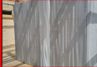
Éléments en BEFUP du Pavillon éphémère JO 2024 de la Fédération de Canoë-Kayak, conçu et réalisé par l'ENSA de Grenoble
