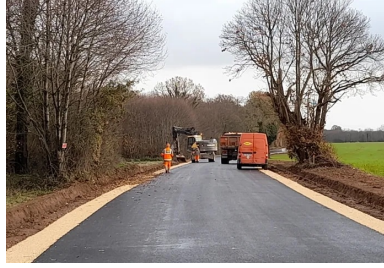
Réalisation des fossés latéraux. (C) Ludovic Pasdeloup/Conseil départemental de la Vienne
