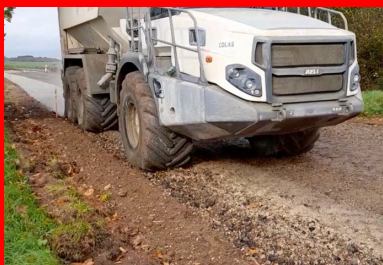
Épandage du liant Ligex M10 à raison de 35 kg/m 2 (dosage 5%) à l'aide d'un épandeur moderne doté d'un système de dosage volumétrique asservi à la vitesse d'avancement. (©Ludovic Padeloup/Conseil départemental de la Vienne)
