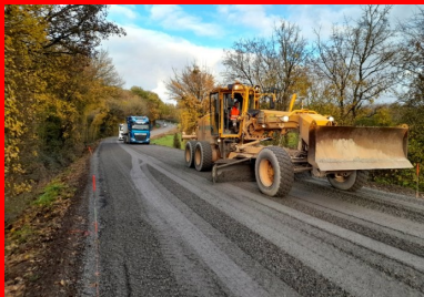
Mise en œuvre de la couche anti-remontée de fissures en grave non traitée sur une épaisseur de 8 cm. (©Ludovic Pasdeloup/Conseil départemental de la Vienne)
