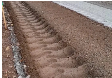
Malaxage du matériau de l'ancienne chaussée avec le liant Ligex M10 sur une profondeur de 35 cm, permettant d'obtenir un matériau homogène sur toute l'épaisseur et sur toute la largeur de la nouvelle chaussée. (© Ludovic Padeloup/Conseil départemental de la Vienne)
