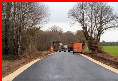
Réalisation des fossés latéraux. (© Ludovic Padeloup/Conseil départemental de la Vienne)
