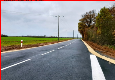
Le tronçon rénové de la RD7 a reçu un nouveau tapis d'enrobés (EB10 sur 6 cm d'épaisseur), avant d'être rouvert à la circulation le 16 décembre 2022. (©Ludovic Pasdeloup/Conseil départemental de la Vienne)
