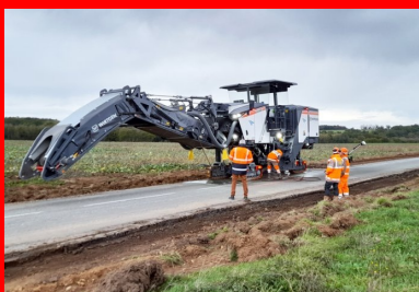
Fragmentation de l'ancienne chaussée sur 15 cm et régalez du matériau décohesionné sur toute la largeur de la nouvelle plate-forme de chaussée. (©Ludovic Padeloup/Conseil départemental de la Vienne)
