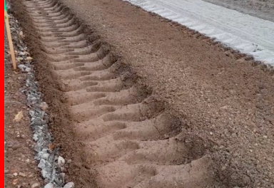
Malaxage du matériau de l'ancienne chaussée avec le liant Ligex M10 sur une profondeur de 35 cm, permettant d'obtenir un matériau homogène sur toute l'épaisseur et sur toute la largeur de la nouvelle chaussée. (© Ludovic Pasdeloup/Conseil départemental de la Vienne)
