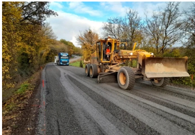
Mise en œuvre de la couche anti-remontée de fissures en grave non traitée sur une épaisseur de 8 cm. (©Ludovic Padeloup/Conseil départemental de la Vienne)
