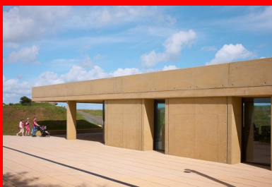
Les voiles de structure en béton de la façade sud rappellent la compacité des abris militaires.
