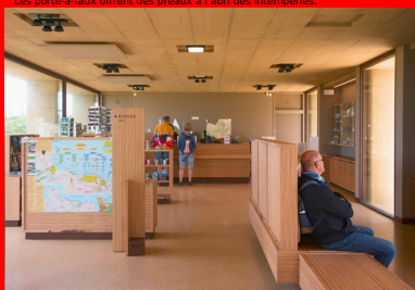
Dans l'office du tourisme le plafond en béton brut est laissé apparent.
