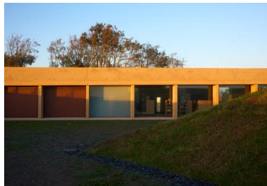
La façade nord est rythmée par les poteaux-lames en béton dont la finesse de la tranche contraste avec l'épaisseur de la dalle qu'ils soutiennent.
