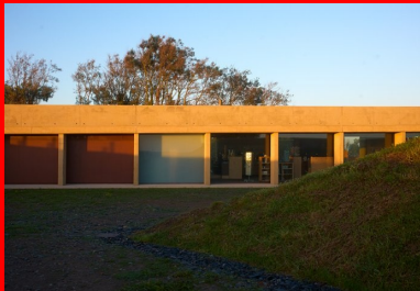
La façade nord est rythmée par les poteaux-lames en béton dont la finesse de la tranche contraste avec l'épaisseur de la dalle qui les soutiennent.
