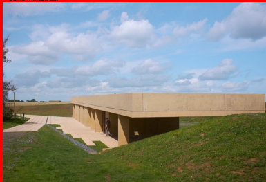
Le béton teinté dans la masse s'accorde aux couleurs et aux matières du paysage environnant.
