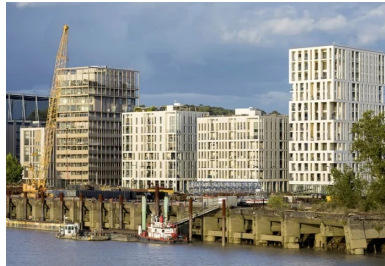
Les constructions situées en bord de Garonne forment un front compact visible de loin.
