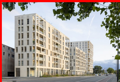
Les trois bâtiments de la résidence créent une séquence urbaine homogène.
