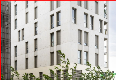
Les façades de béton grège sont rythmées par le matricage des impostes.
