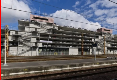
Seuls éléments pittoresques, les émergences en toiture des circulations, parées de marbre rose et baptisées carrelets.
