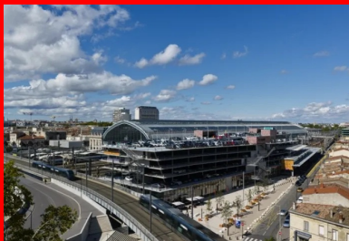
Le béton de ciment clair laissé apparent s'accorde à la pierre blonde du bâti alentour.
