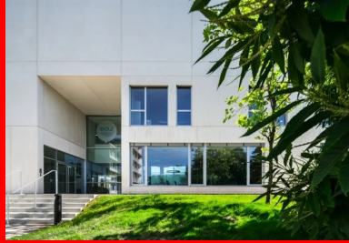
Le hall traversant s'ouvre également au nord et permet de rejoindre directement le centre de formation depuis l'accès principal du site.
