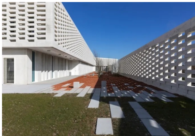
Les éléments préfabriqués des claustras sont réalisés en béton autoplaçant et autonettoyant.
