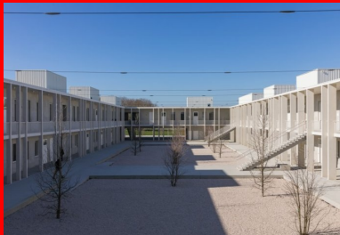
Le bâtiment des classes d'enseignement s'organise autour d'une vaste cour centrale.
