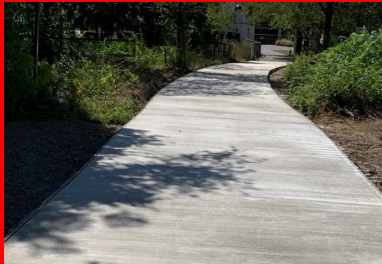
Allée en béton recyclé (100%)
