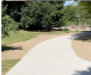
Allée en béton drainant - Au fond Aire de jeux en béton drainant.
