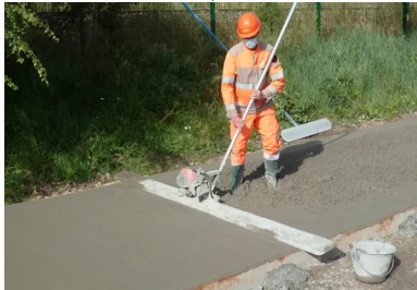
Mise en œuvre du béton manuellement.
