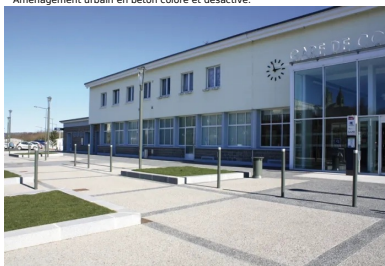
Parvis de gare en béton désactivé.
