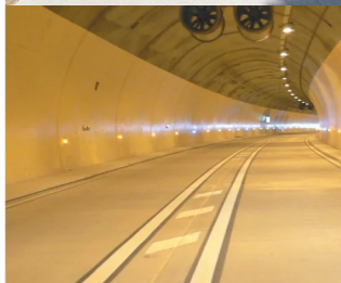
Tunnel en béton.
