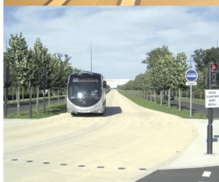
Plate-forme de Bus à Haut Niveau de Service, Melun - Sénart.
