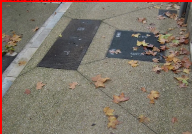
Joint autour des émergences sur trottoir en béton désactivé.
