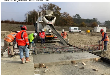
Mise en œuvre du béton à l'aide d'une poutre vibrante.
