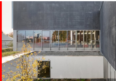
Vue de l'un des patios offerts à une extension extérieure des activités.
