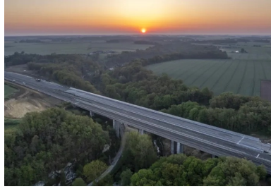
Le viaduc du Courteineau double deux viaducs existants. Il devait respecter leur vocabulaire architectural tout en minimisant son impact sur le milieu naturel.
