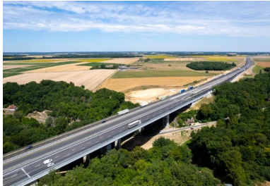
Le viaduc du Courteineau supporte désormais un sens de circulation de l'autoroute A10.
