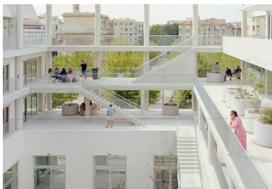
Dans le prolongement de la place de la porte d'Aix, la cour d'accueil regroupe autour d'elle, au rez-de-chaussée, l'espace d'exposition « le Forum », la cafétéria et les amphithéâtres.
