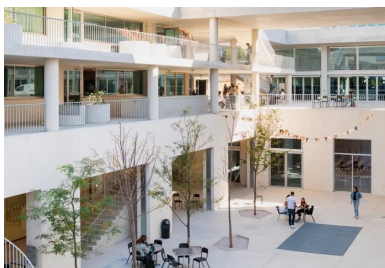
Les ateliers et les salles de cours peuvent s'ouvrir à l'extérieur sur un ensemble de coursives, de passerelles, de loggias ou de terrasses offrant aux étudiants une grande diversité de lieux de travail, de rencontre, de discussion et de détente.
