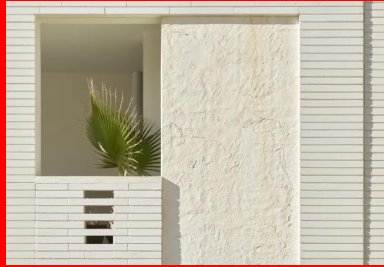
Association de pan de béton froissé et de briques de béton qui caractérise le socle de la résidence.
