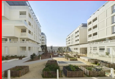
L'intérieur de l'îlot aménagé en cour-jardin est un espace de circulation et de convivialité, commun à la résidence.
