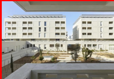
Vue depuis une loggia. Le garde-corps ajouré en briques de béton préserve des regards extérieurs.
