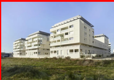
Unifiée par ses façades de béton blanc, la résidence s'élève sur 2 à 5 étages suivant les orientations.
