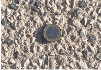
Sablage plus prononcé pour la piste cyclable. (©Joseph Abdo/JA-Consulting)
