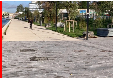
Vue générale de l'aménagement des berges du canal Saint-Denis montrant les différents revêtements réalisés, les espaces verts ainsi que les zones de détente. (© Joseph AbdoJA-Consulting)
