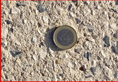
Sablage léger pour la voie piétonne. (© Joseph Abdo/A-Consulting)
