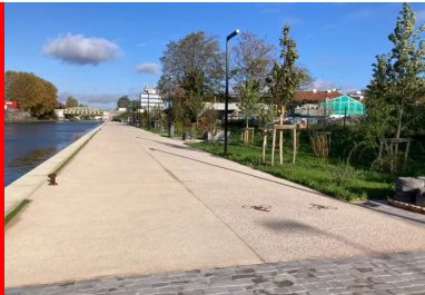
Vue du revêtement en béton avec un sablage léger pour la voie piétonne et un sablage plus prononcé pour la piste cyclable. (© Joseph Abdo/A-Consulting)
