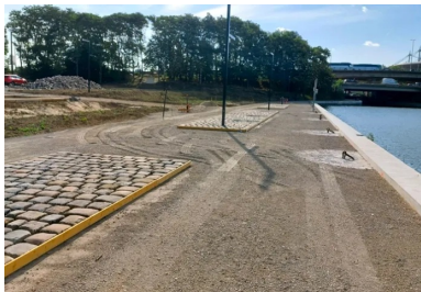
Vue du chantier avant le coulage du béton, montrant la fondation en grave traitée au LHR, les coffrages posés, les bordures de rive et le pavage. (©Sébastien Vinatier/Sols)
