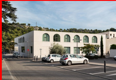
Vue sur l'extension. À chaque baie correspond un bureau.
