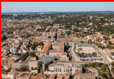
Vue aérienne qui permet de deviner l'emprise initiale du fort et son extension, au nord, dans laquelle prend place le pôle sportif universitaire.
