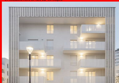
Les briques de béton disposées à claire-voie protègent partiellement des regards les espaces extérieurs tout en laissant filtrer la lumière, naturelle, comme électrique.
