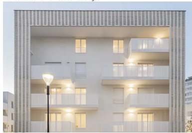
Les briques de béton disposées à claire-voie protègent partiellement des regards les espaces extérieurs tout en laissant filtrer la lumière, naturelle comme électrique.
