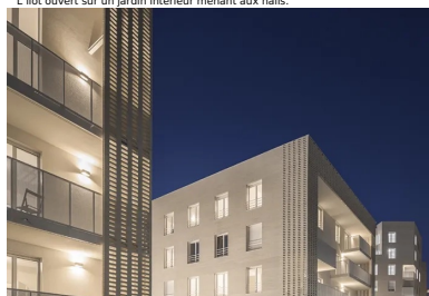
Le mur manteau qui constitue les façades de briques de béton contribue à la protection thermique.
