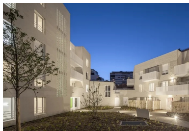
L'îlot ouvert sur un jardin intérieur menant aux halls.
