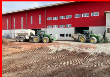
Atelier de traitement. Epandeur tracté Streumaster (à gauche) et Malaxeur tracté Wirtgen WS 250 (à droite). (© Scierie-Gaiffe et Avinim Construction)
