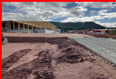
Vue générale du projet d'extension, avec au premier plan la plate-forme des aménagements extérieurs en cours de traitement au liant LV-TS 54. (© Scierie-Gaiffe et Avinim Construction)
