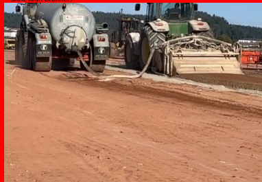
Le malaxeur tracté Wirtgen WS 250 mélange intimement le sol, le liant et l'eau introduite directement dans la cloche du malaxeur. (© SARL Alan Brunner)
