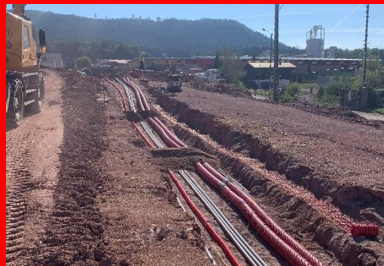
Travaux de réalisation des réseaux secs. (©Lingenheld)
