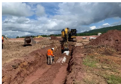
Pose d'un nouveau collecteur des eaux pluviales. (© Lingenheld)
