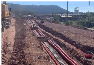
Travaux de réalisation des réseaux secs. (©Lingenheld)
