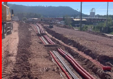
Travaux de réalisation des réseaux secs. (©Lingenheld)
