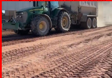
Épandage du liant avec précision à l'aide d'un épandeur tracté Streumaster. (© SARL Alan Brunner)
