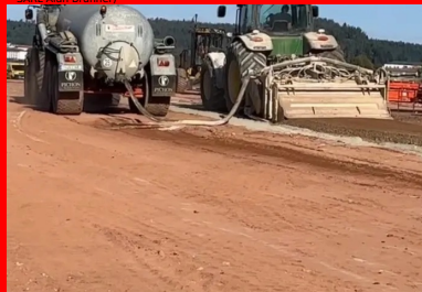
Le malaxeur tracté Wirtgen WS 250 mélange intimement le sol, le liant et l'eau introduite directement dans la cloche du malaxeur. (© SARL Alan Brunner)
