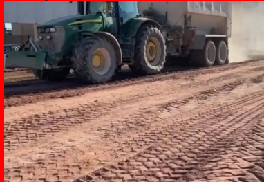
Épandage du liant avec précision à l'aide d'un épandeur tracté Streammaster. (© SARL Alan Brunner)
