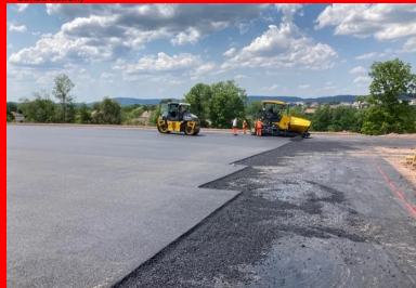
Mise en œuvre de la couche de surface en BBSG. (© Scierie-Gaiffe et Avinim Construction)
