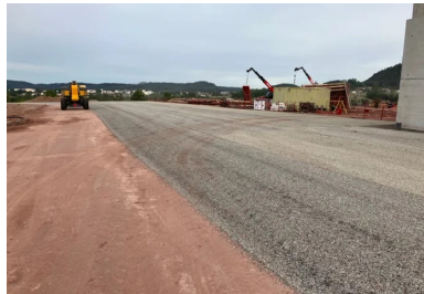
Enduit de cure pour protéger le sol traité. (© Scierie-Gaiffe et Avinim Construction)
