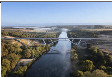
Un pont-passerelle en arc au-dessus de la Mayenne
