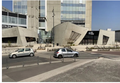
La façade principale de l'extension (côté sud) se caractérise par le jeu des surfaces gauches en béton qui la rythme et par sa composition en triptyque.
