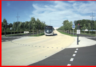
Photo 5 : Plate-forme en béton pour Bus à Haut Niveau de Service BHMS, Melun-Sénart (C) CIMbéton
