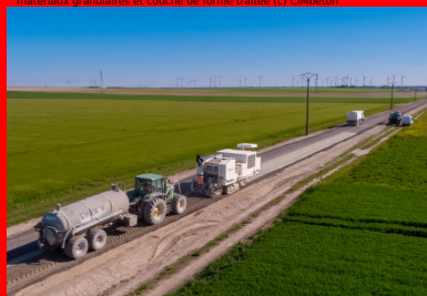
Photo 2 : chantier de retraitement des chaussées en place à froid aux liants hydrauliques routiers (c) CIMbéton
