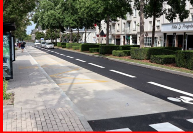
Photo 6 : Chaussée renforcée en béton à un arrêt de bus à Angers/Transbus.org
