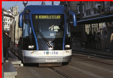
Photo 4 : arrêt et voie de tram omniérés, en cours d'usure avancée- (c) CIMbéton
