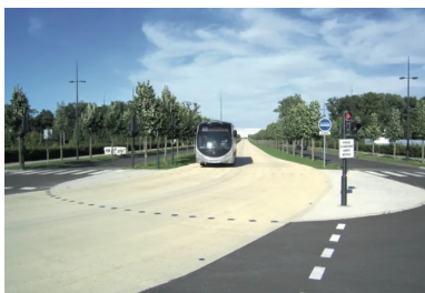
Photo 5 : Plate-forme en béton pour Bus à Haut Niveau de Service BHNS, Melun-Sénart (c) CIMbéton
