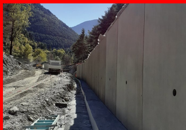
Mur Chapsol pour la brèche n° 72.
