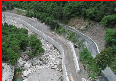
RD 91. Brèches n° 2 et 3 : réalisation d'un mur cantilever en béton coulé en place (8 m de haut) surmonté d'un deuxième mur en ModBloc® (mur poids en blocs béton préfabriqués).
