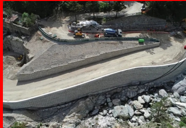
RD 91. Reconstruction des lacets du lac des Mesches avec des murs en remblais renforcés en RediRock® pour garantir une esthétique soignée.
