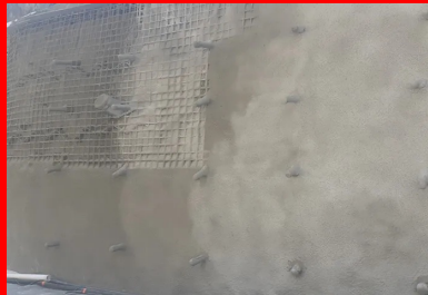
Paroi clouée, brèche n° 40.
