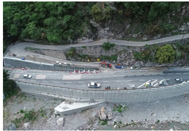
RD 6204. Réalisation d'une paroi AD/OC® et d'une paroi clouée en béton projeté pour la brèche 18b.
