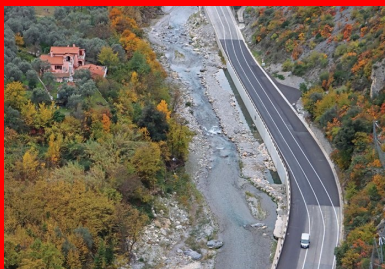
Saorge, RD 6204, Brèche n° 12 : réalisation d'un mur cantilever en béton coulé en place.
