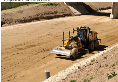
Réglage à la niveleuse pour obtenir un profil en long très régulier. (© Colas)
