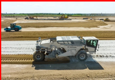
Le sol est malaxé avec le liant à l'aide d'un pulvimixeur moderne. Au fond, un compacteur en action. (©Colas)
