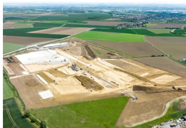
Vue générale du chantier de terrassement. (©Colas)
