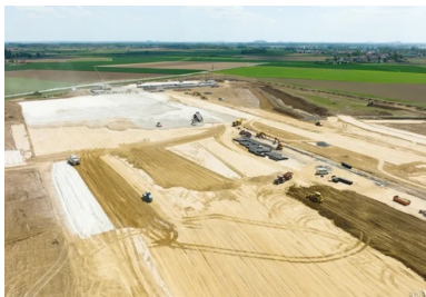
Vue générale des travaux de terrassement de la plate-forme logistique d'Illies et Salomé. (©Celas)
