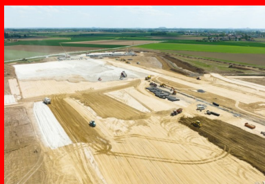
Vue générale des travaux de terrassement de la plate-forme logistique d'Illies et Salomé. (© Colas)
