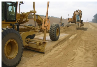
Mise à la cote du matériau avant le passage de l'atelier de traitement. (©Colas)
