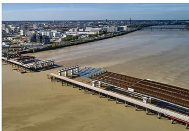
Le tablier du pont repose sur huit piles pleine largeur en béton armé constituées chacune de quatre fûts carrés.
