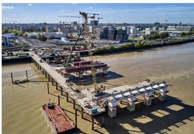
Les travaux de fondations et d'élevation des piles sont réalisés depuis des estacades (perpendiculaires au fleuve) et des épis (parallèles) provisoires.
