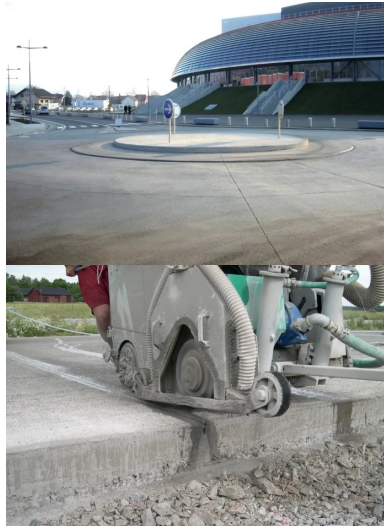
Vue d'un carrefour giratoire à Chambéry (© CIMbéton)
