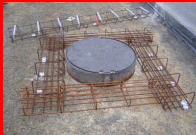
Chaînage bordant un regard.
