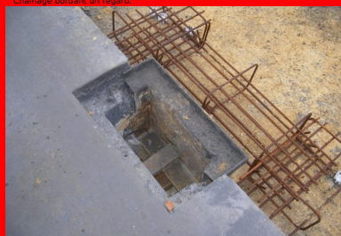
Chaînage autour d'un avaloir.
