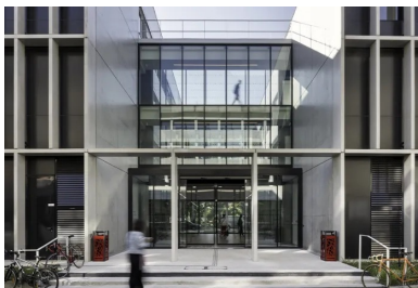
Le hall d'entrée, entièrement vitré et traversant, fait le lien entre les deux volumes les plus importants.
