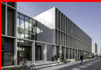
Côté nord, la résille de béton d'une épaisseur de 40 cm s'adapte à l'orientation et s'amincit.
