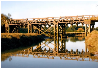
Construit en 1916, le pont du Marais peut être considéré comme un prototype en tant que premier pont en béton au monde entièrement préfabriqué et assemblé sur place. Il a bénéficié d'un financement européen pour sa restauration. (© DR)
