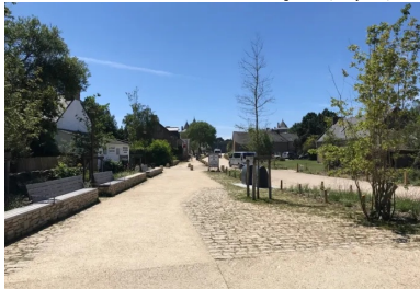
L'entrée dans le hameau de Kermoizan après aménagement. (©Phytolab)
