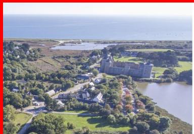
La traversée du hameau de Kermoizan, avant les travaux d'aménagement. (© Département du Morbihan)
