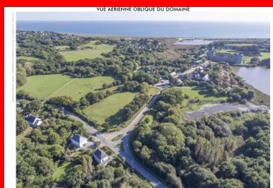
Vue aérienne du domaine de Suscinio et l'accès par la RD198A ou route du Duc-Jean-V, avant les travaux de rénovation. (© Département du Morbihan)
