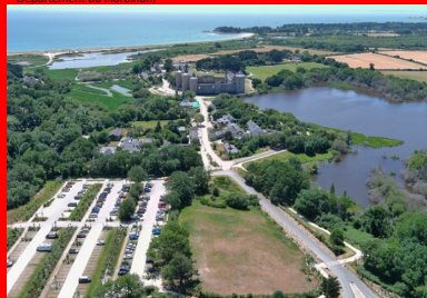
Le stationnement d'accueil nord, après les travaux d'aménagement. (© Phytolab)
