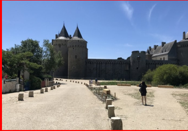
L'avant du château de Suscinio, le belvédère après les travaux d'aménagement. (© Phytolab)
