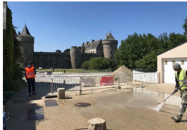
Désactivation du béton au jet d'eau à haute pression. (© Phytolab)
