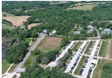
Vue aérienne du stationnement d'accueil. (© Phytolab)
