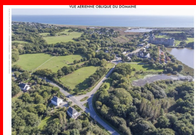
Vue aérienne du domaine de Suscinio et l'accès par la RD198A ou route du Duc-Jean-V, avant les travaux de rénovation. (© Département du Morbihan)
