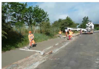
Mise en œuvre manuelle du béton, livré par camion toupie équipé de tapis. (© CIMbéton)
