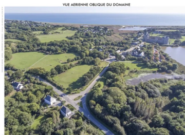
Vue aérienne du domaine de Suscinio et l'accès par la RD198A ou route du Duc-Jean-V, avant les travaux de rénovation. (© Département du Morbihan)
