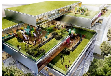
Hôpital Mater - Dublin (Irlande). En dégageant de vastes plateaux, les planchers précontraints par post-tension permettent une grande flexibilité dans l'aménagement intérieur. Cette flexibilité est particulièrement précieuse dans les hôpitaux, où l'espace peut devoir être réaménagé pour répondre à de nouvelles exigences ou technologies médicales. Par ailleurs, la grande capacité portante de ces planchers leur permet de supporter facilement de lourds équipements médicaux (scanners, équipements de radiologie...). © NBB Architects
