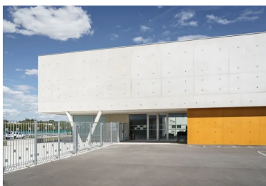
Le hall de l'école élémentaire se développe transversalement à la séquence d'entrée et offre en transparence une vue sur le patio central.
