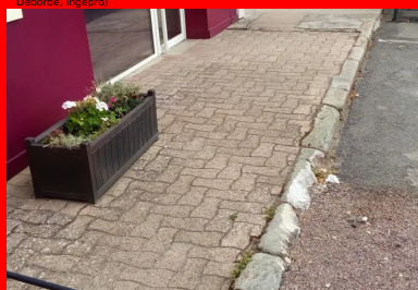
La place du Champ-de-Foire avant les travaux de rénovation. (C)Jean-Sébastien Deborde, Ingepro
