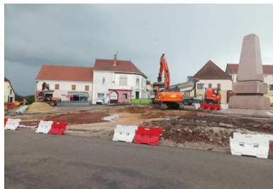
Travaux de démolition et de réalisation de la plate-forme support. (©Jean-Sébastien Deborde, Ingepro)
