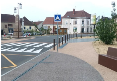
Vue générale après aménagement de la place du Champ-de-Foire à Saint-Bonnet-de-Joux. (C)Jean-Sébastien Debordé, Ingepro
