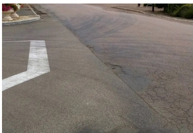
La place du Champ-de-Foire avant les travaux de rénovation. (C)Jean-Sébastien Debordé, Ingepro
