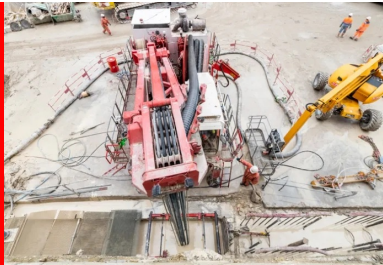
Excavation en cours dans la tranchée d'un panneau de la future paroi moulée. La boue bentonitique affleure. Celle-ci est injectée au fur et à mesure de la réalisation de l'excavation. Ces propriétés thixotropiques lui permettent de stabiliser les parois du trou de forage et d'empêcher le sol de s'effondrer.
