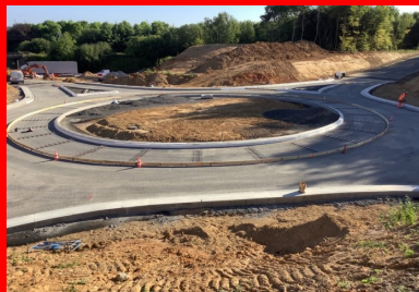
Réalisation du coffrage de l'anneau interne entre la bordure béton qui sert aussi de coffrage et le coffrage bois. Les paniers de goujons sont positionnés et fixés dans la grave-bitume. (© Quentin Hognon, Colas)
