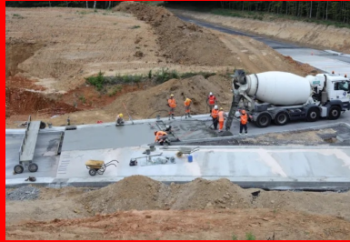
Contrôle de la consistance du béton à l'aide de l'essai d'affaissement au cône d'Abrams. (© Quentin Hognon, Colas)
