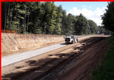
Malaxage du liant avec le matériau de la couche de forme à l'aide d'un pulvimixeur moderne. (© Bruno Barberot, Colas).
