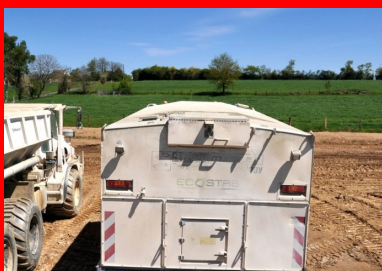
Épandage du liant ROC VDS à l'aide d'un épandeur moderne asservi.
