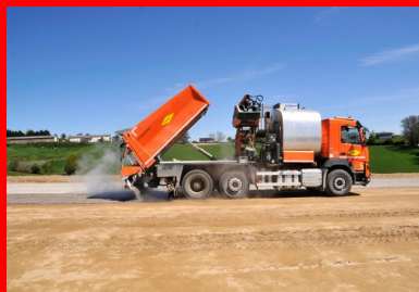
Protection de la couche de forme.
