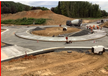
Bétonnage de l'anneau intérieur du carrefour giratoire. (© Quentin Hognon, Colas)
