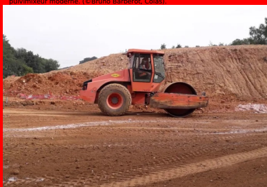
Compactage de la couche de forme. (© Bruno Barberot, Colas).
