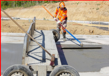
Talochage de la surface du béton. (© Joseph Abdo, JA-Consulting)
