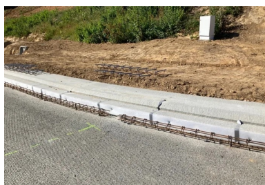
Les chainages ont été mis en place pour renforcer les bords de dalles sollicités ainsi qu'au droit des joints de dilatation. (© Quentin Hognon, Colas)
