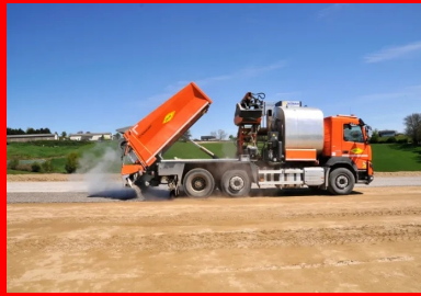
Protection de la couche de forme.
