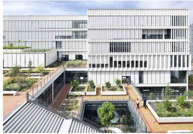
Le cœur d'îlot est animé de patios qui permettent d'assurer l'éclairage naturel d'un maximum de locaux.
