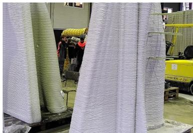
Des coques en béton imprimées 3D par dépôt de couches successives sont apposées sur la structure en béton armé pour servir de coffrage.
