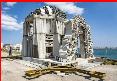
Au cœur du village de récifs artificiels, le module central mesure 6,50 m de haut sur une base de 48 m 2 .
