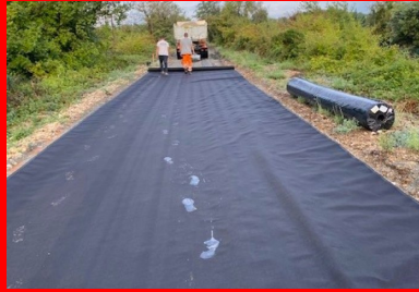
Mise en place d'un géotextile sur l'ensemble de la plate-forme. (© Jacob Gouvenaux, Braja Vésigné)
