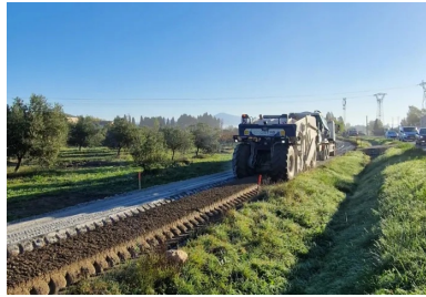
La voie verte Via Venaissia sur le tronçon entre Jonquières et Orange. (© Bruno Montagnini_Ecostab)
