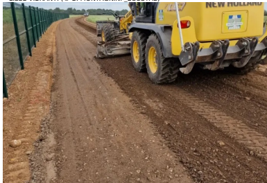
RÉGLAGE FIN DE LA PLATE-FORME TRAITÉE A L'AIDE D'UNE NIVELEUSE. (© B. MONTAGNINI _ECOSTAB)
