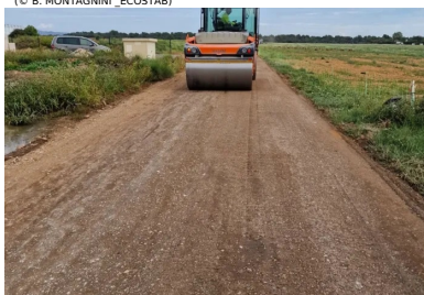
LE COMPACTAGE DU MATERIAU TRAITÉ A L'AIDE D'UN COMPACTEUR MONOBILLE LISSE VIBRANT. (© B. MONTAGNINI _ECOSTAB)
