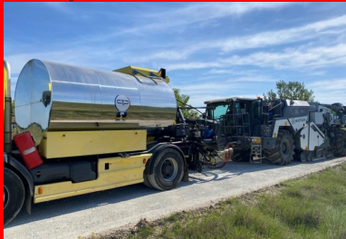
UN MALAXAGE ET LES DERNIERS AJUSTEMENTS EN TENEUR EN EAU JUSQU'A L'OBTENTION DE LA TENEUR OPTIMALE SE FONT EN INJECTION D'EAU DIRECTEMENT DANS LA CLOCHE DU PULVIMIXEUR (© JACOB GOUVENAUX, BRAJA VESIGNE)
