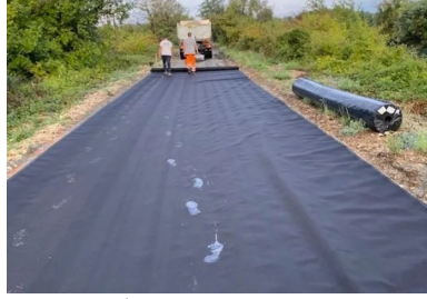
Mise en place d'un géotextile sur l'ensemble de la plate-forme. (© Jacob Gouvenaux_Braja Vesigne).
