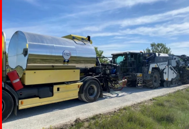
UN MALAXAGE ET LES DERNIERS AJUSTEMENTS EN TENEUR EN EAU JUSQU'A L'OBTENTION DE LA TENEUR OPTIMALE SE FONT EN INJECTION D'EAU DIRECTEMENT DANS LA CLOCHE DU PULVIMIXEUR (© JACOB GOUVENAUX, BRAJA VESIGNE)
