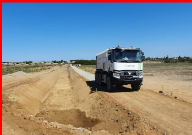
EPANDAGE DU LIANT HYDRAULIQUE ROUTIER LVTS 13 A L'AIDE D'UN EPANDEUR MODERNE STREUMASTER SW18 (COEFFICIENT LTV EST EGAL A 333). (© B. MONTAGNINI _ECOSTAB)
