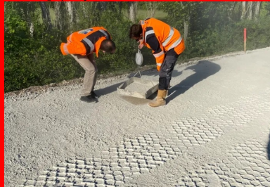
Contrôle de l'épandage du liant à l'aide de la méthode dite à la bêche. (© Jacob Gouvenaux, Braja Vésigné)
