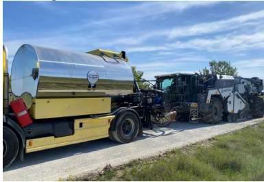
UN MALAXAGE ET LES DERNIERS AJUSTEMENTS EN TENEUR EN EAU JUSQU'A L'OBTENTION DE LA TENEUR OPTIMALE SE FONT EN INJECTION D'EAU DIRECTEMENT DANS LA CLOCHE DU PULVIMIXEUR (© JACOB GOUVENEAUX BRAJA VESIGNE)
