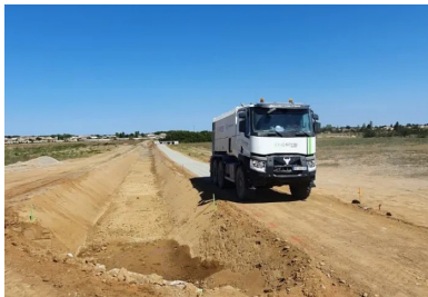
EPANDAGE DU LIANT HYDRAULIQUE ROUTIER LVT5 13 A L'AIDE D'UN EPANDEUR MODERNE STREUMASTER SW18 (COEFFICIENT LTV EST EGAL A 333). (© B. MONTAGNINI _ECOSTAB)
