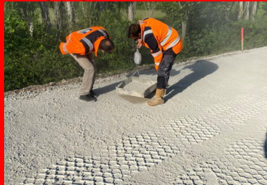
Contrôle de l'épandage du liant à l'aide de la méthode dite à la bêche. (© Jacob Gouvenaux, Braja Vésigné)
