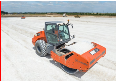
Atelier de compactage de la couche de forme traitée. (© Colas)
