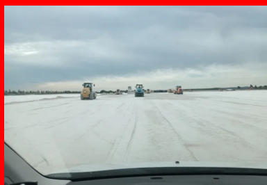
Préparation de la PST afin de conférer à l'arase les caractéristiques topographiques et mécaniques. (© Colas)
