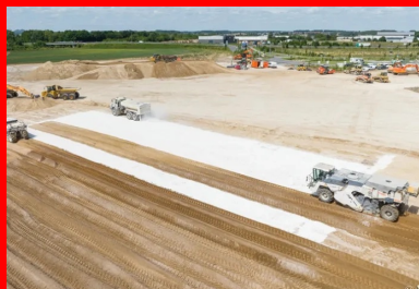
Atelier de traitement de la couche de forme au ROC VDS. Epandeur asservi et malaxeur moderne en action. (© Colas)
