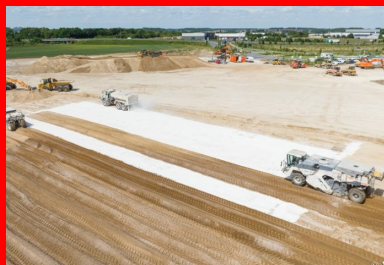
Atelier de traitement de la couche de forme au ROC VDS. Epandeur asservi et malaxeur moderne en action. (© Colas)
