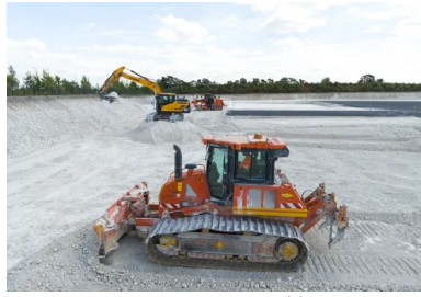
Extraction de la craie et constitution d'une zone de dépôt provisoire. (© Colas)
