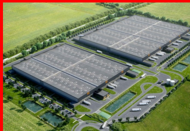
Vue d'artiste du nouveau parc logistique Logisterra, dont la livraison est prévue au troisième trimestre 2023. Achevé, le bâtiment principal aura une superficie de 102 000 m 2 .
