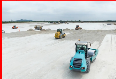
Acheminement de la craie et mise en œuvre de celle-ci en couches de 40 cm et 50 cm. (© Colas)
