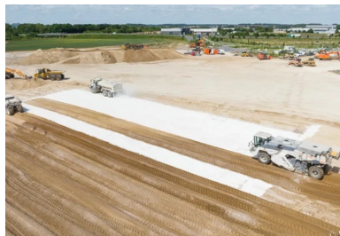
Atelier de traitement de la couche de forme au ROC VDS. Épandeur asservi et malaxeur moderne en action. (© Colas)
