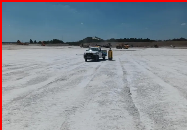
Mesure de portance de l'arase non traitée à la dynaplaque. (© Colas)
