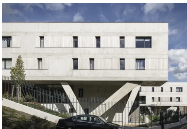
Le soulèvement d'une partie de la barrette de logements par des poteaux obliques allège la masse bâtie.
