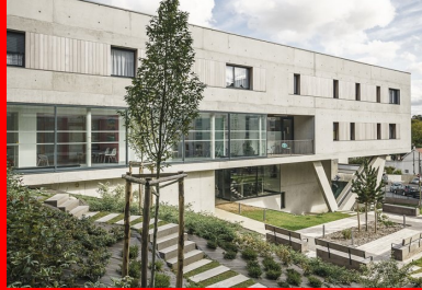
Façade ouest côté jardin. La simplicité formelle apparente du bâtiment contraste avec le terrain accidenté sur lequel il se déploie.
