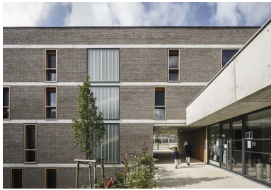
Façade est en brique. Le mail qui longe le local associatif rejoint la rue et offre une percée visuelle sur l'intérieur de l'îlot.
