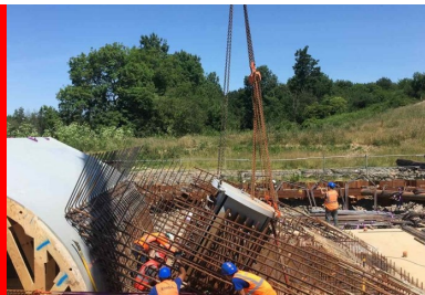
Amorce de pied d'arc en cours de réalisation. La précision de positionnement des différentes parties de l'ouvrage constituait l'un des défis techniques du chantier pour NGE GC. Ainsi, les inserts métalliques noyés du pied d'arc (platinés d'appareils d'appui et pièces d'ancrage) sont positionnés avec une précision de \pm 0,3 millimètres. © photothèque NGE
