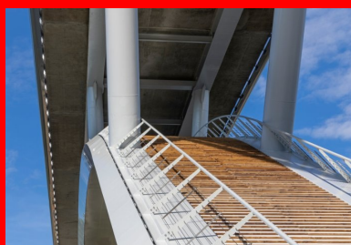
L'extrados de l'arc est utilisé comme une passerelle piétonne. 140 marches en bois de largeur variable sont positionnées sur chacune des pentes de l'arc et donnent accès à une plateforme belvédère située à la clé, à 25 mètres au-dessus de la Mayenne. © Xavier BOYMOND
