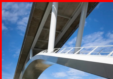
Soutenant le tablier mixte acier-béton par l'intermédiaire de pilettes disposées en « éventail », l'arc est constitué de deux segments rectilignes reliés au centre par un arc de cercle tangent. © Xavier BOYMOND
