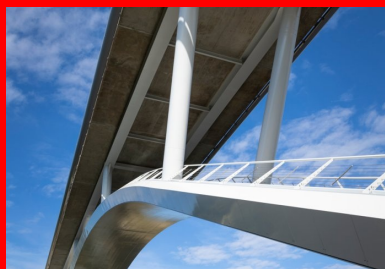
Soutenant le tablier mixte acier-béton par l'intermédiaire de pilettes disposées en « éventail », l'arc est constitué de deux segments rectilignes reliés au centre par un arc de cercle tangent. © Xavier BOYMOND
