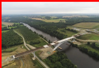
Le hourdis en béton armé du tablier du viaduc a été réalisé à l'aide de deux équipages mobiles (structures blanches sur la photo) par pianotage : les plots, d'une longueur comprise entre 1,3 et 1,5 mètres, étaient coulés dans un ordre permettant d'équilibrer l'ouvrage pendant son chargement tout en limitant les risques de fissuration de la dalle. © Auteurs De Vues
