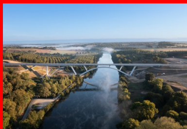
Situé à quinze minutes à pied du centre-ville de Château-Gontier, le viaduc de la Mayenne est l'ouvrage majeur du contournement routier nord de la sous-préfecture de la Mayenne. Son arc structurel de 122 mètres de portée enjambe majestueusement la rivière. © Xavier BOYMOND
